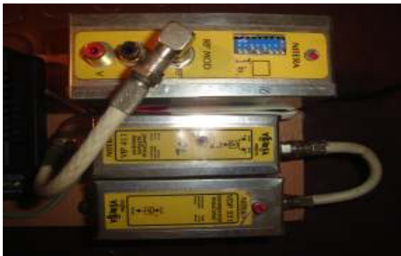
Elementi po kanalu
